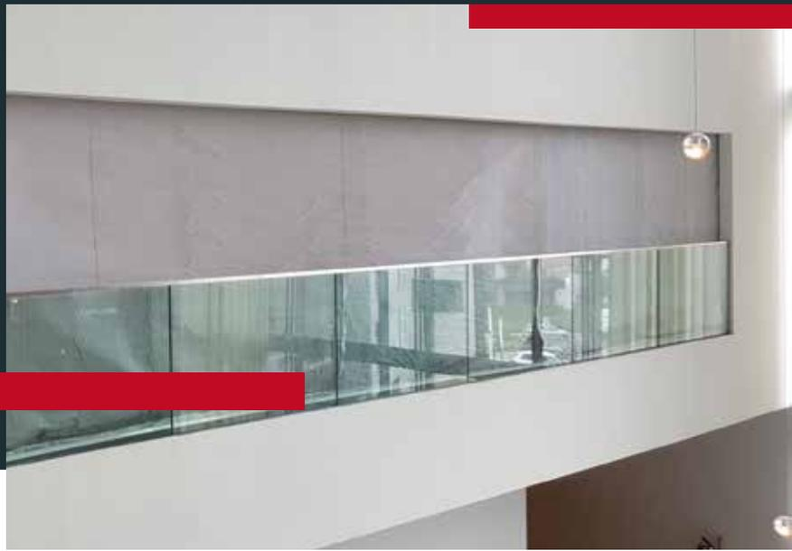
Der BSV-E/EW ist ein automatischer Brandschutzvorhang, der im Brandfall Feuer effektiv begrenzt und kontrolliert. Mit einer E120-Klassifikation erfüllt er die höchsten Anforderungen an Sicherheit und Schutz in modernen Gebäuden.
