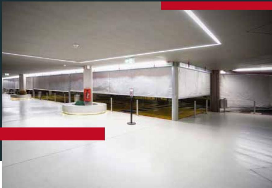
Der BSV-E-EI ist ein automatischer Brandschutzvorhang mit EI 120-Klassifikation, der im Brandfall nicht nur das Feuer begrenzt und kontrolliert, sondern auch die Strahlung und Wärmeübertragung reduziert. Durch seine isolierenden Eigenschaften schützt er Personen und Güter optimal.
